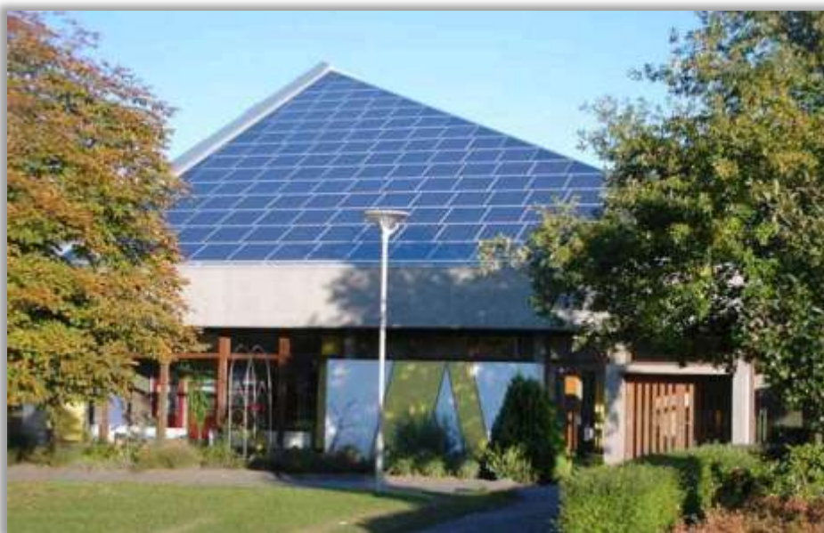
Abb. 17: Solardach der Evangelisch-lutherischen Kirchgemeinde Seckenhausen (25)
