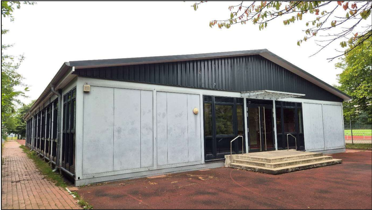
Abb. 7: Mobilgebäude, von Osten gesehen
